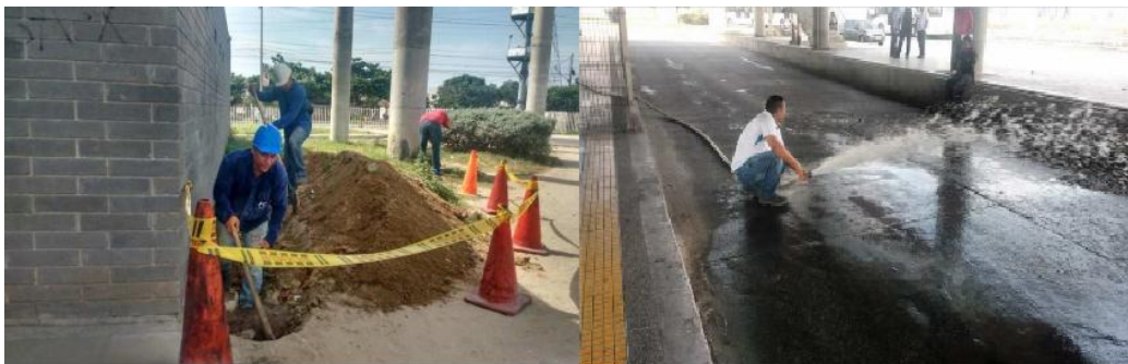
Reparación Sistema Contra Incendios
