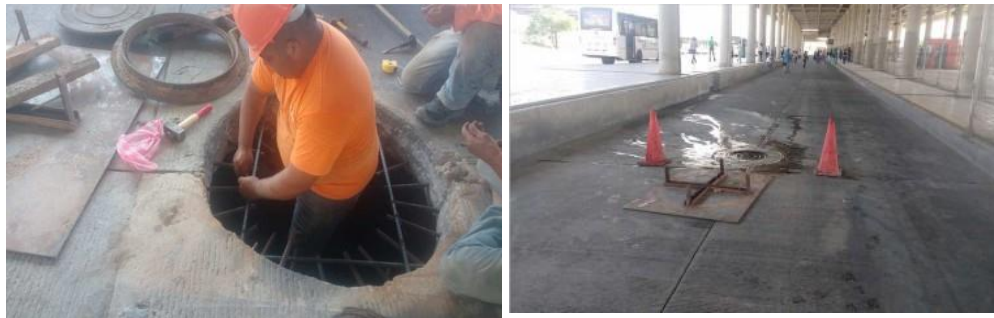
Reparación Manhole Vía Rutas Alimentadoras
