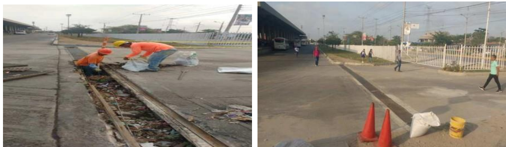
Reparación Cárcamo De Aguas Lluvias Acceso Sur
