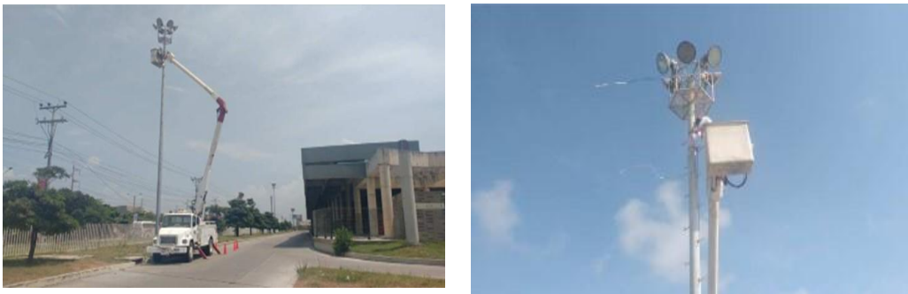
Reparación Mástiles Luminarias Vía Articulados
